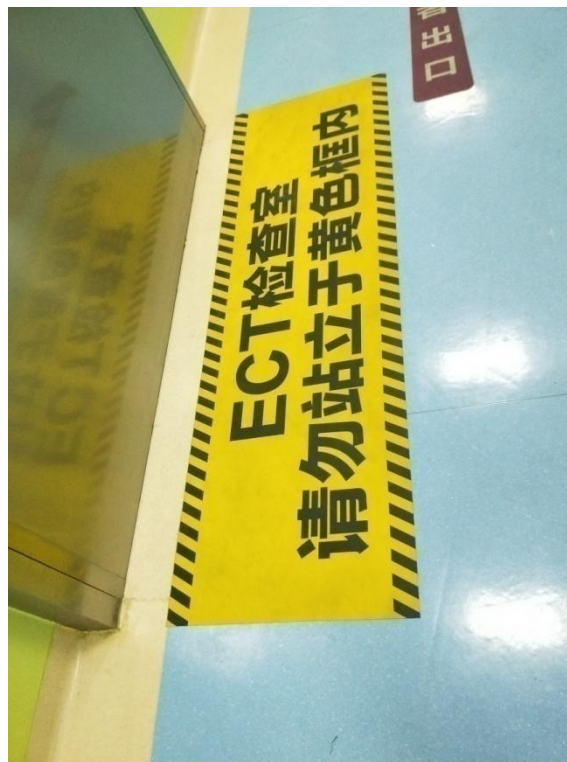
机房防护门外黄色警示地标
